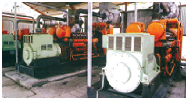
Электрические генераторы, работающие на шахтном метане: Группа по добыче антрацита «Джиншенг», Китай.
